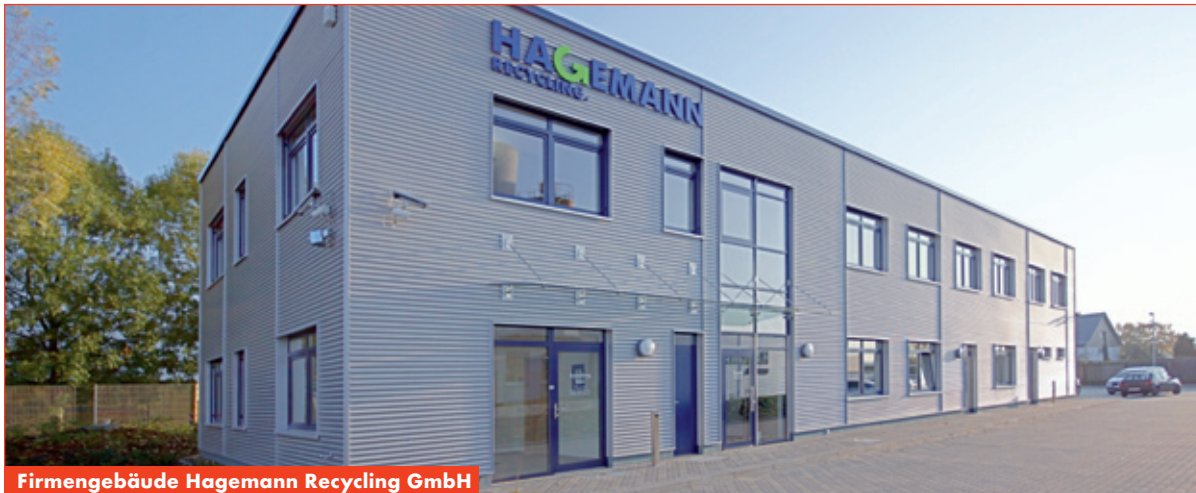
Firmengebäude Hagemann Recycling GmbH
