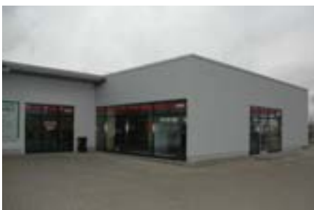
Vergrößerung der Ausstellungsfläche durch den neuen Anbau.
